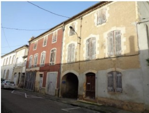
Vic-Fezensac - Ensemble immobilier vacant de grande taille dont la reconquête implique des travaux conséquents
